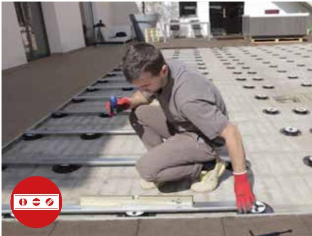
Determinare di ogni intersezione le pendenze e la tipologia di piedistallo necessaria per compensare eventuali dislivelli.
